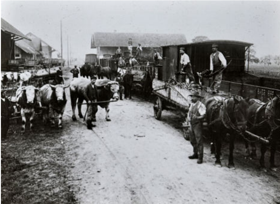
«Herbstverkehr» beim «Arbeiterheim Nusshof» der Strafanstalt Witzwil im Jahr 1925. Die Fotografie zeigt eine Schnittstelle des agrarischen Landtransports: Rinder- und Pferdefuhrwerke – im Vordergrund Doppelgespanne, im Hintergrund ein Dreiergespann – und das Verladen der Fracht auf die Eisenbahn. (Archiv für Agrargeschichte, Glasdiasammlung der Anstalten Witzwil, 0153, AfA-ID 33)
