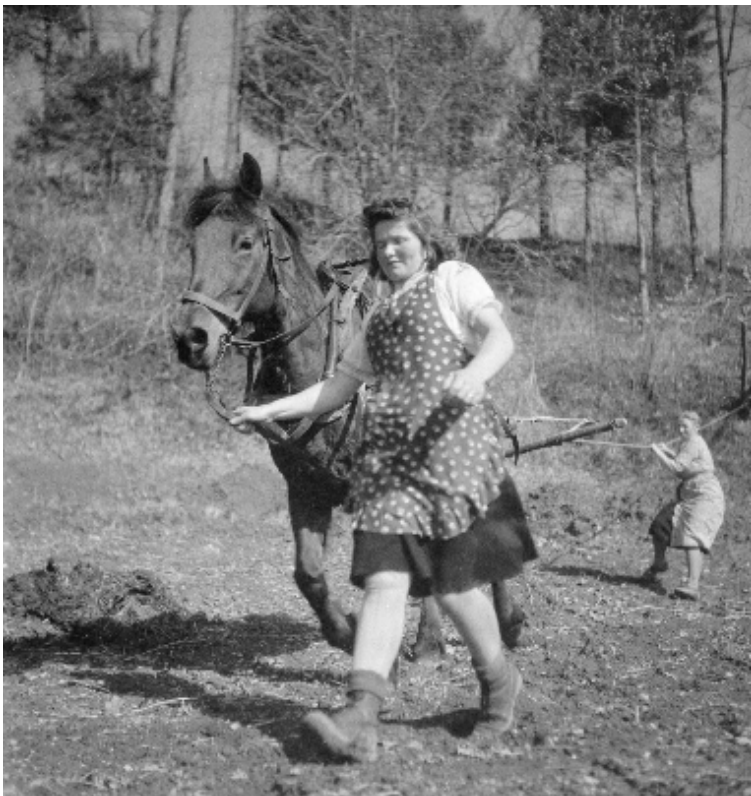
Erdtransport am Wohlensee bei Bern im Jahr 1942. Das Pferd zieht über eine Umlenkswelle bergab, während die Erde aufwärts transportiert wird. (Eugen Thierstein, Burgerbibliothek Bern, N Eugen Thierstein 376A/16)
