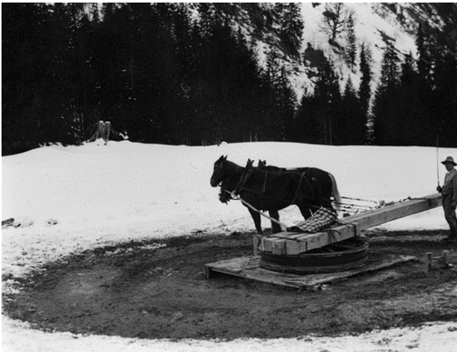
Strafanstalt Witzwil, Aussenstation Berghof Killy. Göpel als Antrieb einer Seilbahn für den Materialtransport im Jahr 1930. (Archiv für Agrargeschichte, Foto-Nr. 0717)
