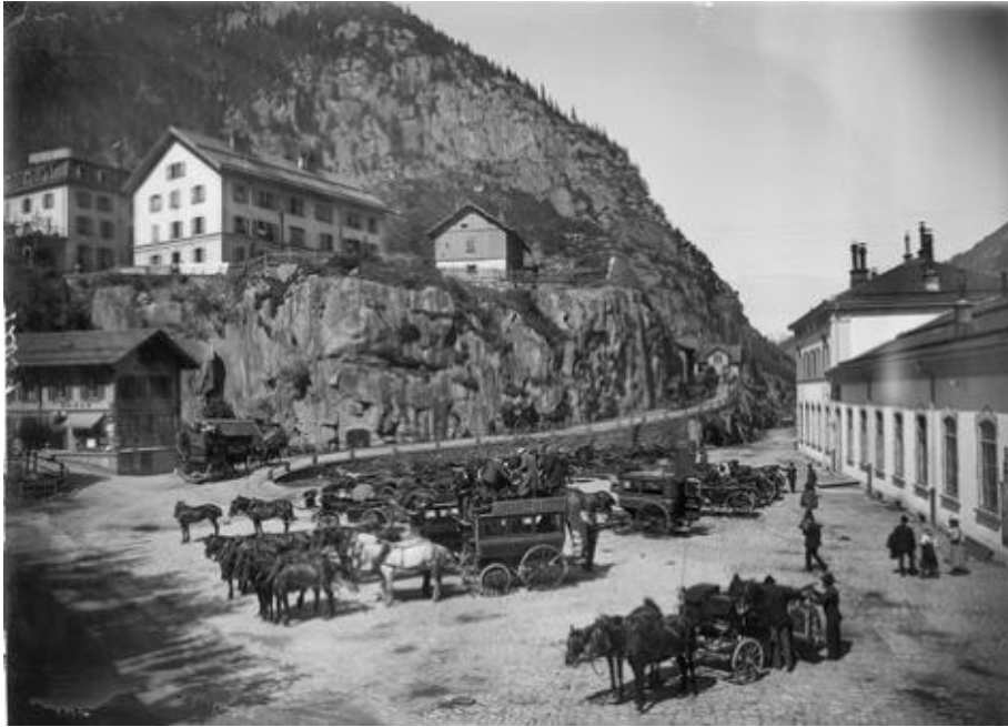
Kutschen und Omnibusse vor dem Bahnhof Göschenen zu Beginn des 20. Jahrhunderts. (Wehrli, Schweizerische Nationalbibliothek, Eidg. Archiv für Denkmalpflege, EAD-WEHR-12059-B)
