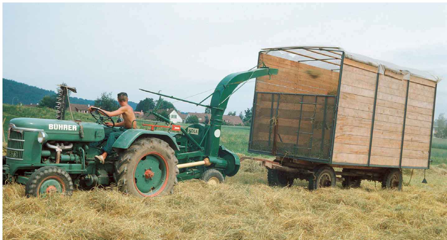
Die Zapfwelle verhalf der Motorisierung in der Landwirtschaft zum Durchbruch. Erst jetzt wurden die Traktoren zu vielseitig verwendbaren Kraftzentren, die die Pferde als Zugtiere verdrängten.
