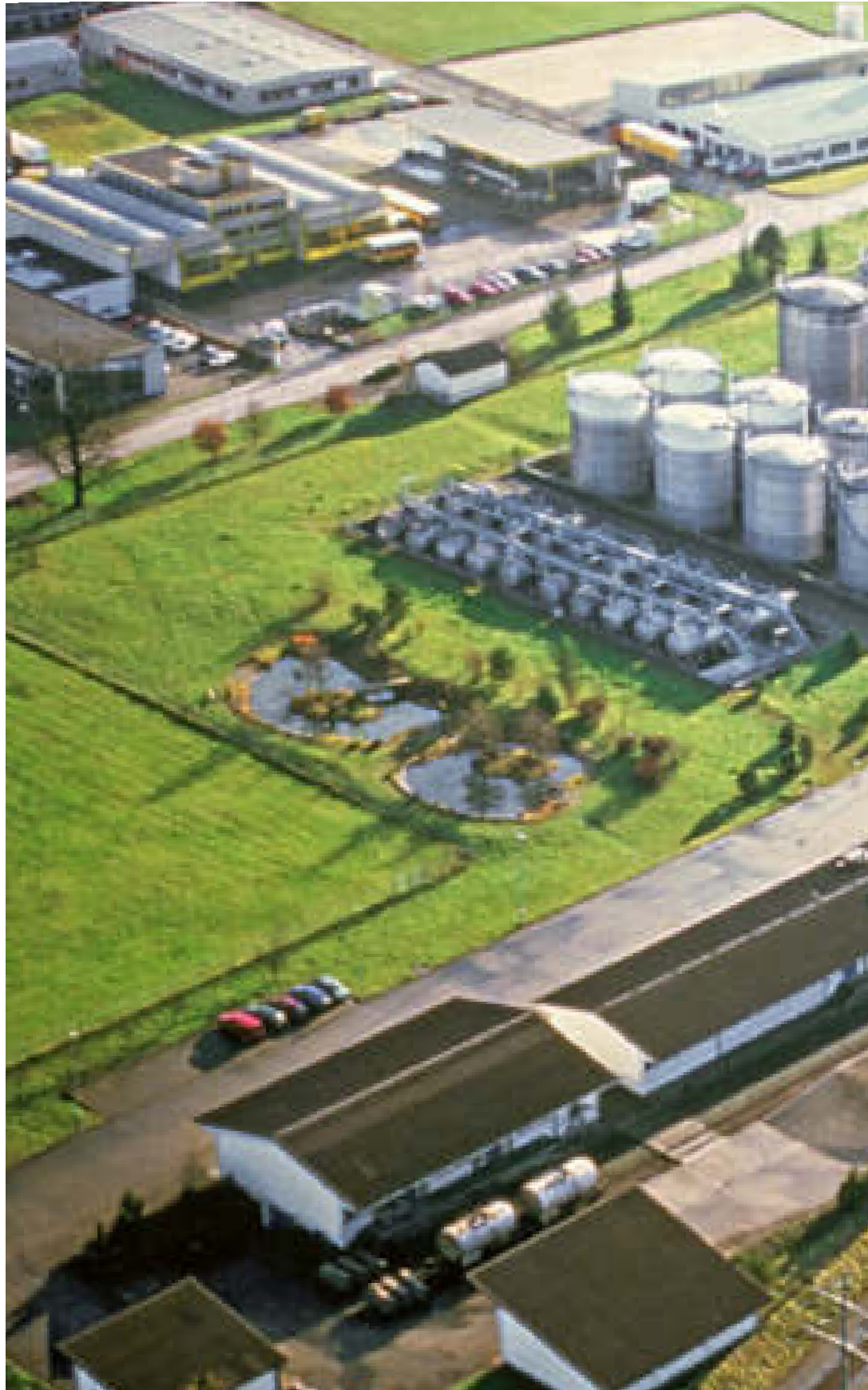
5.4.5 L'entrepôt de Delémont vu du ciel: récipients, citernes, conduites, voie ferrée, wagons-citernes et bâtiments restent au début du 21 e siècle un ensemble imposant qui appartient à la Confédération.
