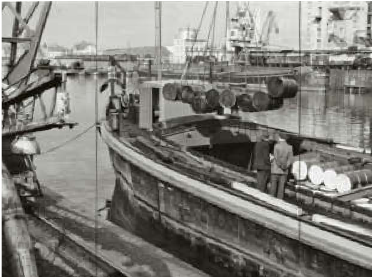
2.3.3 Pour répondre à la demande ou limiter les coûts, il est parfois nécessaire d'importer de grandes quantités d'alcool industriel. Photo: transbordement de marchandises au port rhénan de Bâle.
