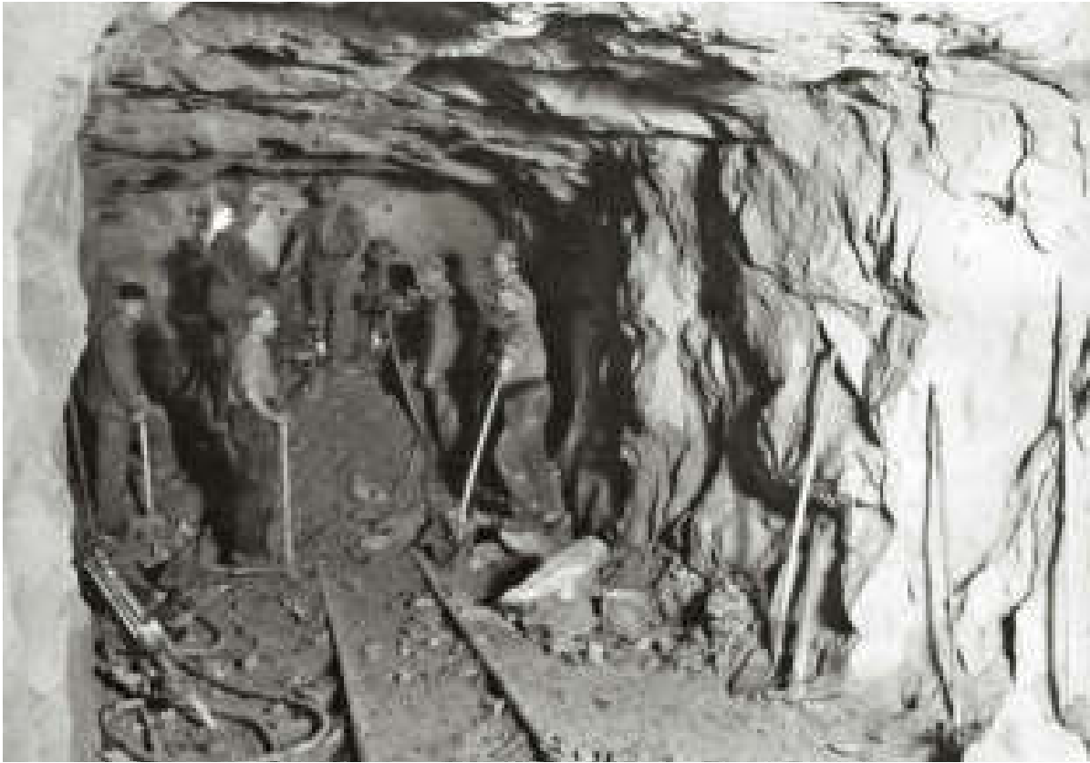
3.5.3 Zur Vergrößerung der Sicherheit und der Lagerhaltung baute die EAV 1940 im Depot Schachen ein Stollen.
