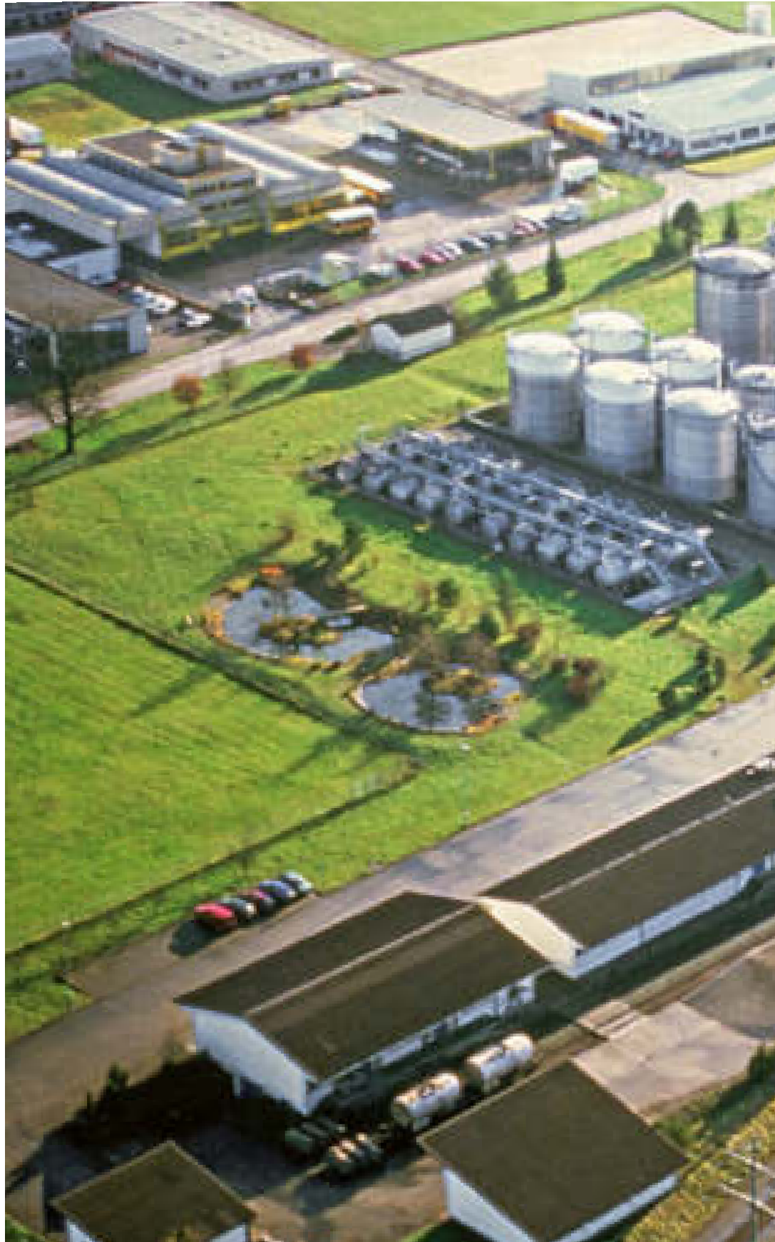
5.4.5 Luftaufnahme des Alkohollagers in Delémont: Stehbehälter, Tankanlagen, Rohrsysteme, Eisenbahnschienen, Tankwagen und Betriebsgebäude bilden auch zu Beginn des 21. Jahrhunderts ein imposantes Ensemble des Bundesbetriebes.
